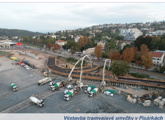
Výstavba tramvajové smyčky v Pisárkách
