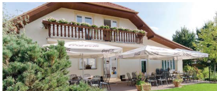
ParaCENTRUM Fenix, budova k rekonstrukci v Modřicích
