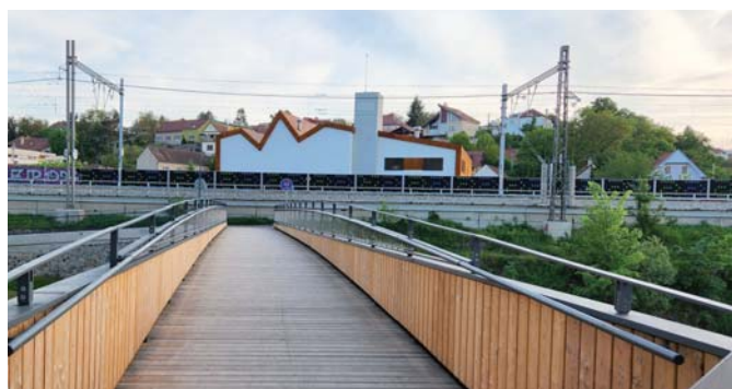
Lávka v Bílovicích nad Svitavou
